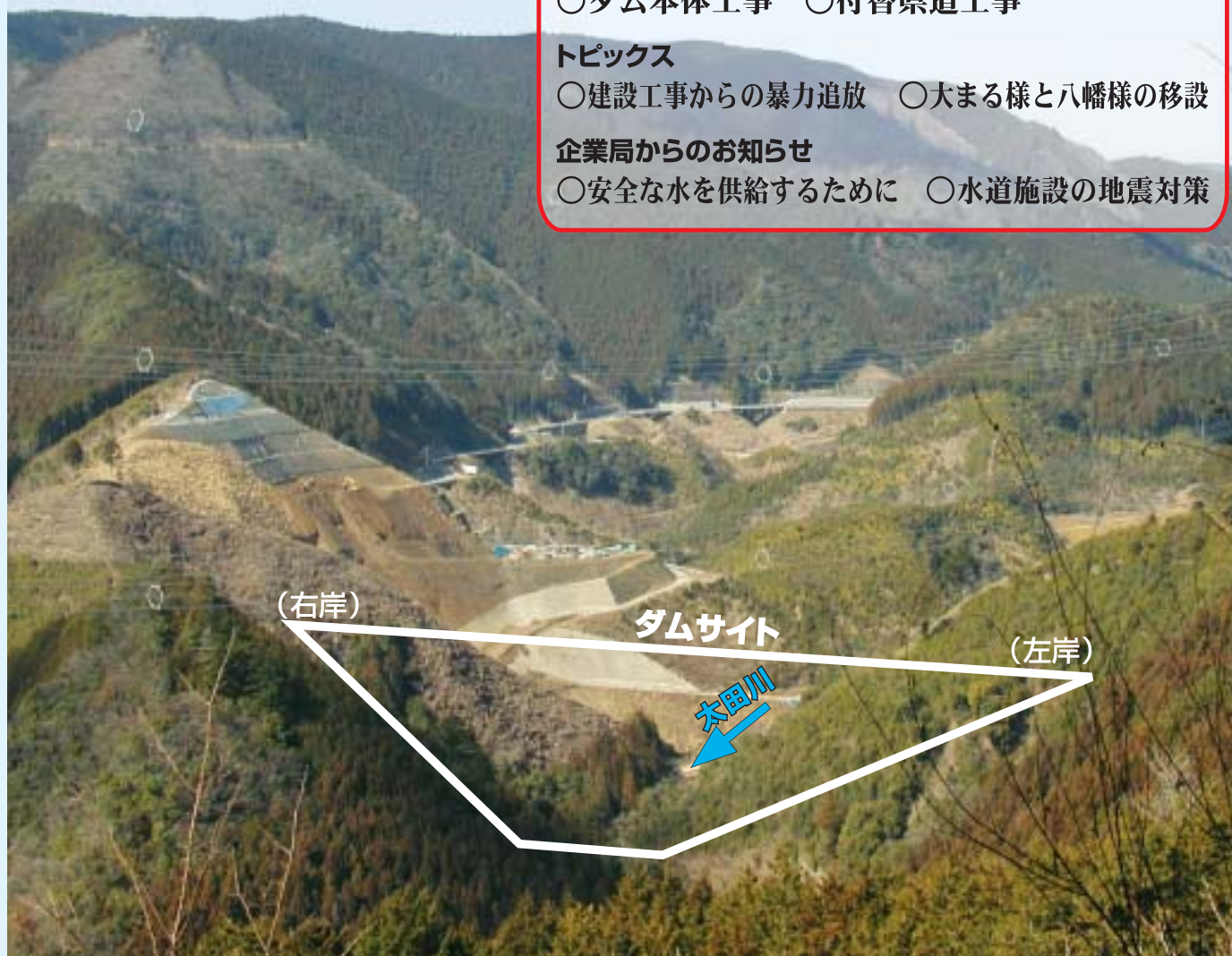
▲ダム本体付近を望むと、右岸側の掘削箇所がはっきりと見えてきました。(平成15年2月撮影)
