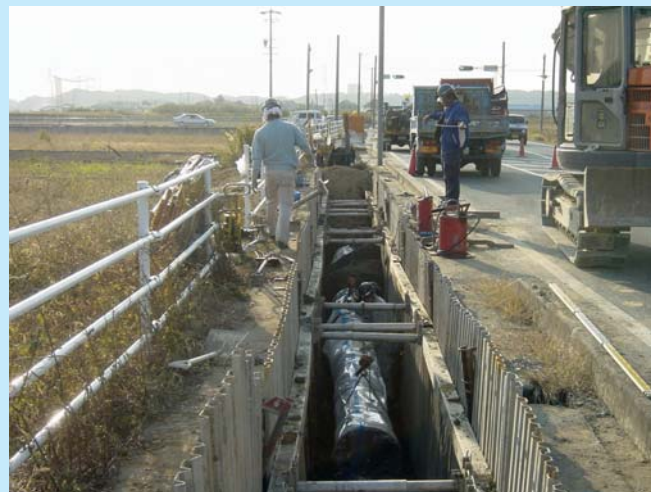
送水管の布設状況
