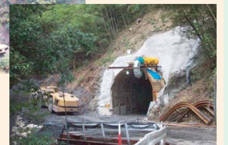
▼下流側から掘り進められました。（下流側坑口）
