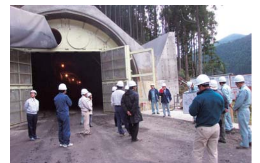
▼トンネルの防音扉の設置等を確認しました。
