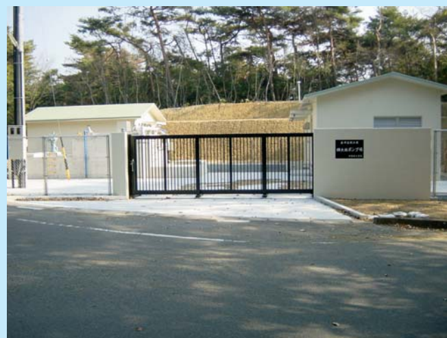
四大地ポンプ場
