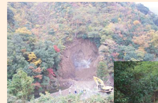
▲貫通の瞬間です。白煙は発破によるものです。（上流側より）
