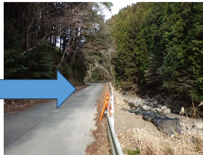
大河内森線 復旧後
