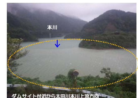
貯水池に流入した濁水が、沈み込んだ後に、堤体付近(常用洪水吐き付近)で再浮上して拡散している様子(平成30年9月4日)
