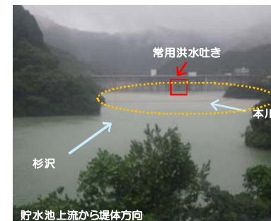
貯水池に流入した濁水が、沈み込んだ後に、堤体付近(常用洪水吐き付近)で再浮上して拡散している様子(平成30年9月4日)
