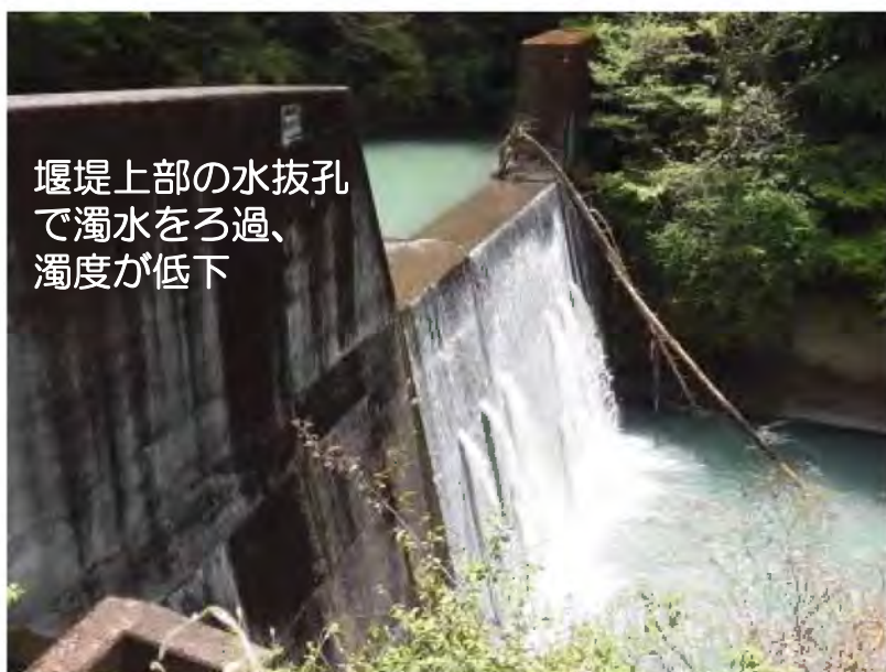
礫間浄化工事完了 (H29.3)
