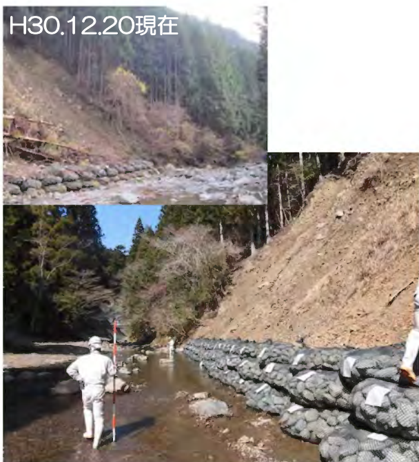
工事① 崩落防止工事完了（H29.3）
