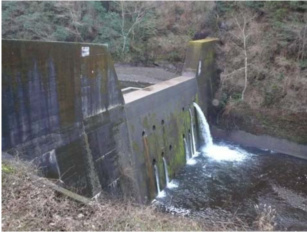
亀久保堰堤における 水抜き穴からの清水流出状況
