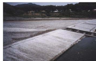
森 町 睦 実 頭 首 工 (平 成 6 年) (濁 水 時)
