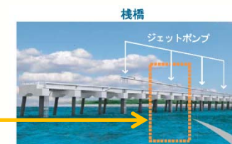
栈橋は、福田漁港西防波堤から沖に向かって設置されています。栈橋にはジェットポンプを取り付け、海底から土砂を採取します。
