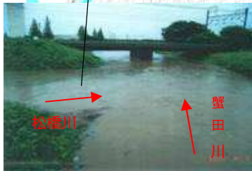
平成17年9月洪水 蟹田川の出水状況 (JR 東海道橋梁付近)
