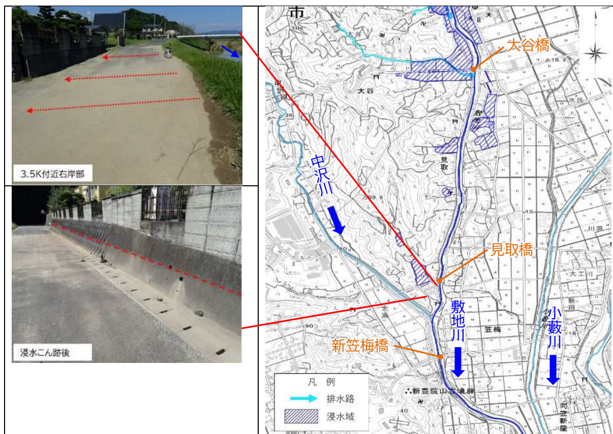
図 3.9 見取橋～大谷橋の被害発生状況（令和 4 年 9 月洪水）
