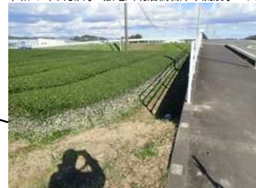
令和4年9月洪水 敷地川大谷橋右岸上流浸水エリア
