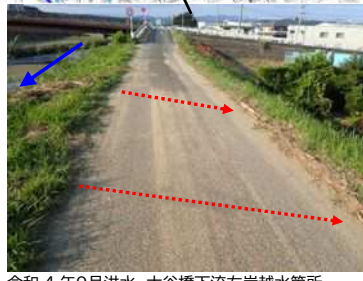
令和4年9月洪水 大谷橋下流左岸越水箇所
