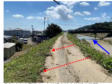
令和4年9月洪水 大谷橋上流左岸越水箇所
