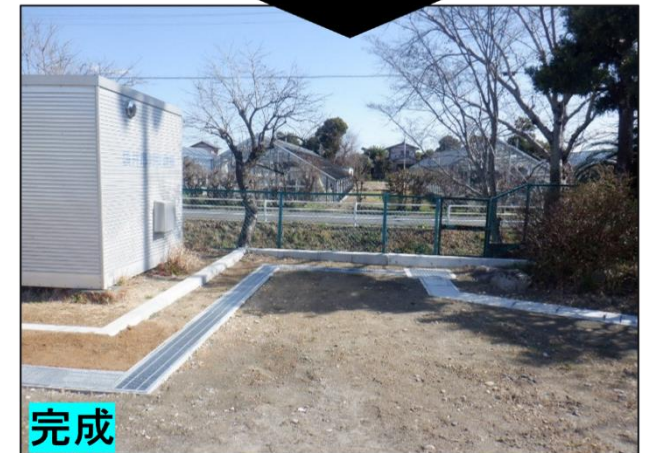
施工事例：今井小学校
