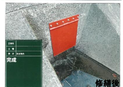
＜R7応急修繕＞
