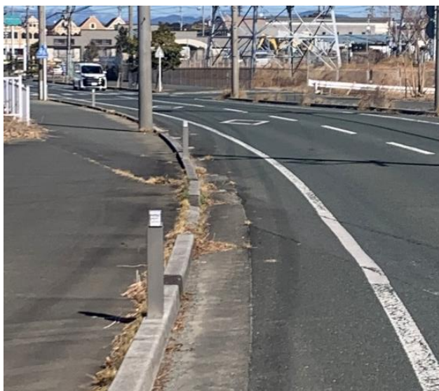
冠水検知ユニット設置(富士見台中泉幹線)
