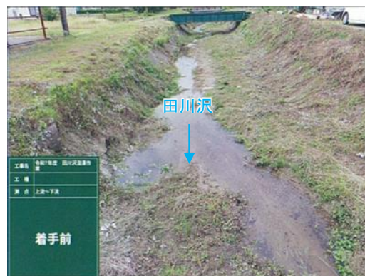
工事着手前：写真位置
