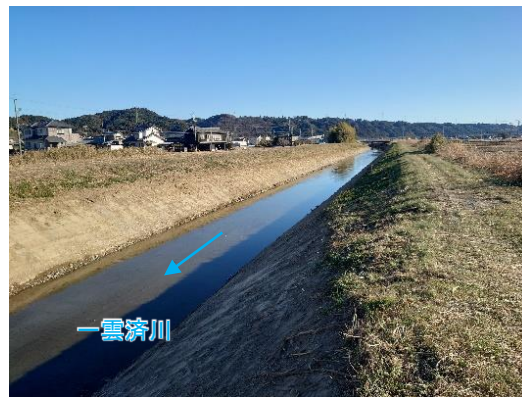
工事完了後：写真位置① (上野部川合流点下流)
