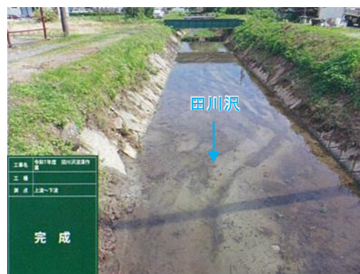
工事完了後：写真位置
