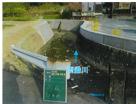
工事完了後：写真位置①
