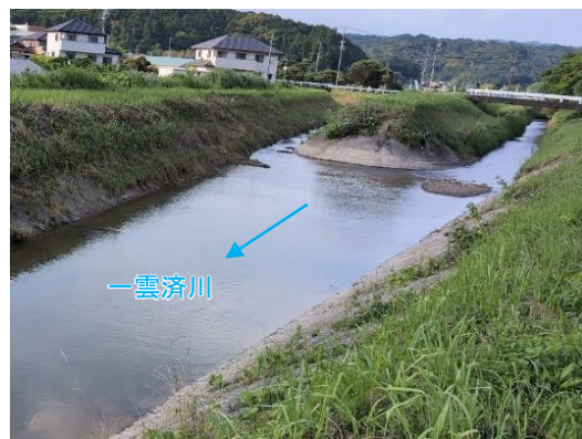
工事完了後：写真位置② (田川沢合流点)
