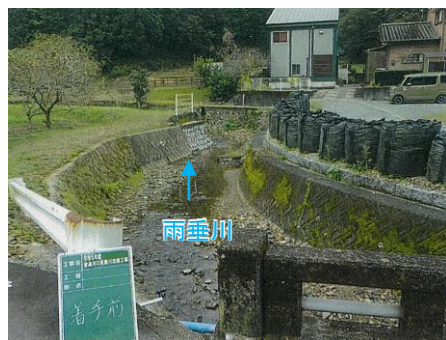
工事着手前：写真位置①
