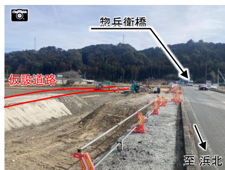
惣兵衛橋上流に仮設する架設道路の工事状況
