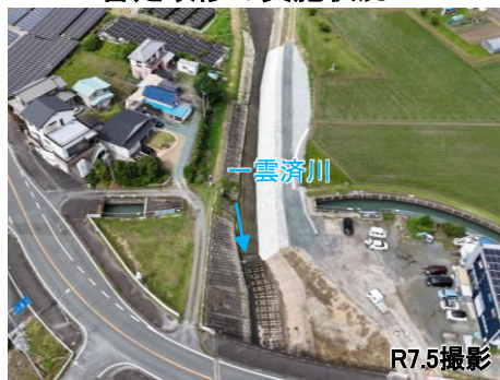
現況：写真位置① (谷口橋上流)
