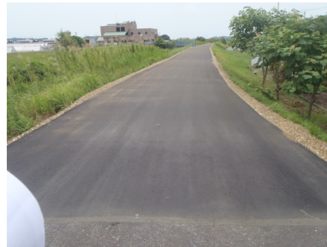
西方川の実施状況 (完成)
