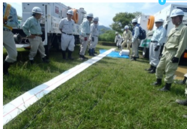
排水ホース設置訓練状況
