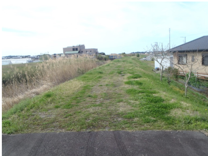
西方川の実施状況 (着手前)
