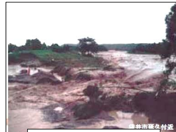
太田川(袋井市延久) 昭和49年7月洪水による破堤写真
