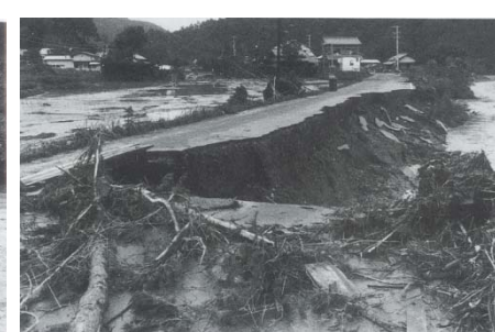
三倉川(森町黒石・県道袋井春野線) 昭和49年7月洪水による破堤写真
