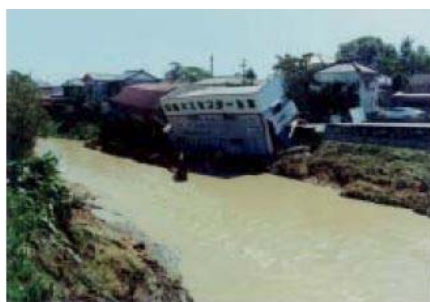
逆川(掛川市内) 昭和57年9月洪水による決壊写真
