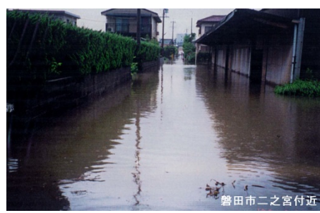
今ノ浦川(磐田市二之宮) 平成10年9月洪水による内水被害写真
