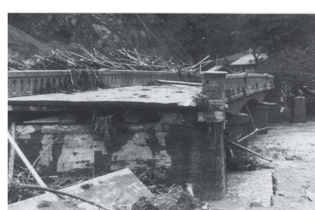
三倉川(森町黒田・巖橋) 昭和49年7月洪水による破堤写真
