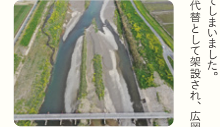
▲河川敷にかかる神原橋
