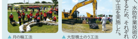
▲月の輪工法：土のうを積み上げている ▲大型積土の工法
