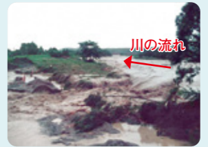
▲資料① 太田川堤防の破堤(袋井市延久)
