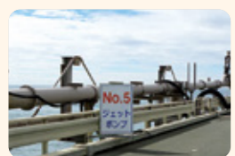
▲ 棧橋に設置されている排砂管やジェットポンプ
