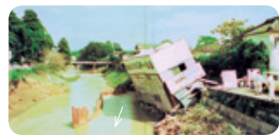
▲旧松尾橋より上流を見る。(S57) 一部、護岸崩壊により建物が倒壊した。
