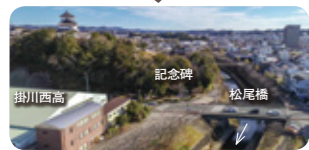
▲安全な逆川に生まれ変わった。
