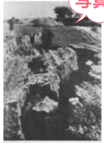
磐田市南御厨で発生した地割れと液状化 昭和19年撮影：故宮内良太郎氏
