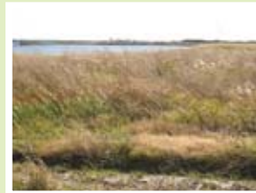
写真2の地割れ現場 平成25年撮影
