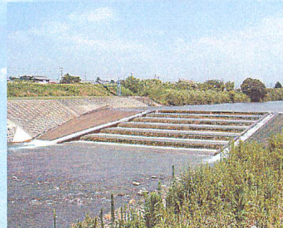
原野谷川の要塞？ 原野谷川の広岡頭首工
