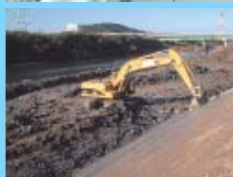
川幅を広げる工事を推進しています
