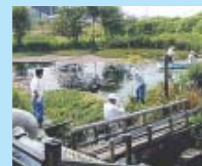
おいしげる水草の除去作業中
