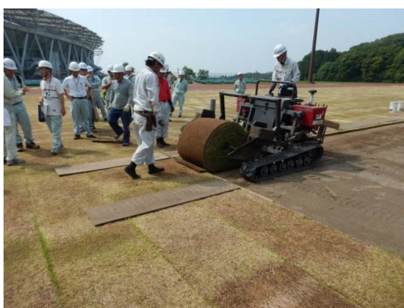
インストーラによる芝の敷設
