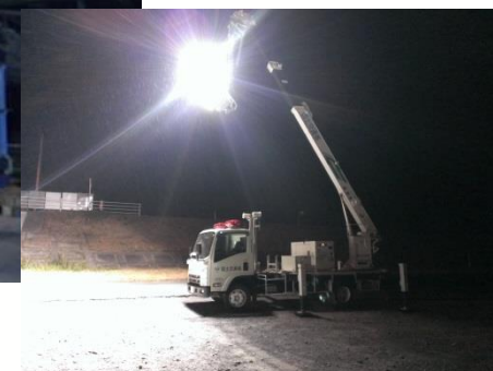
夜間作業に国交省の照明車が威力を発揮
