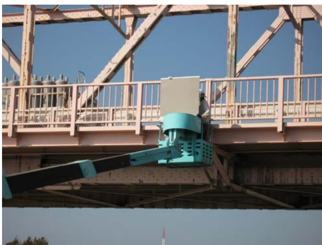
掛塚橋：色見本による色合わせ状況
