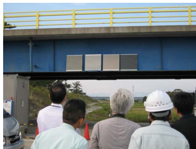
太田川橋：色見本による色合わせ状況
