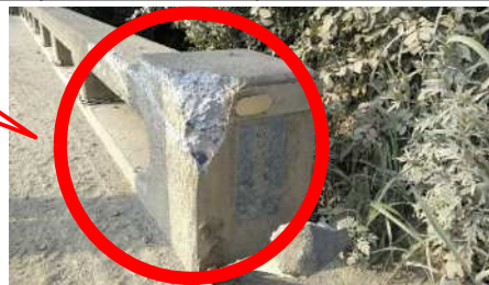
一部欠損した橋梁の親柱
