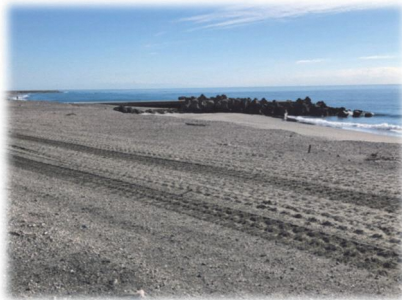
浜松五島海岸の突堤整備 (2015(H27)年～)
