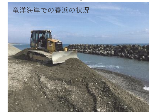
天竜川河道掘削土砂を活用した海岸養浜
