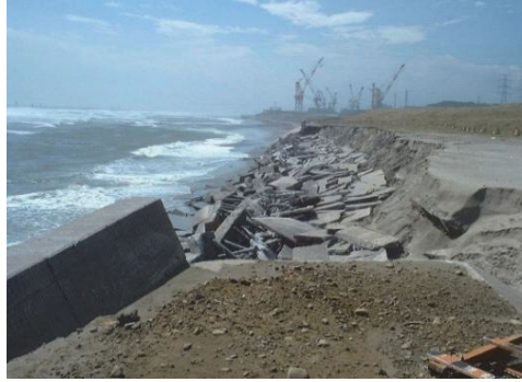
御前崎海岸（2001(H13)年8月） 台風に伴う高波浪の影響で、護岸が大規模に崩壊しました。
