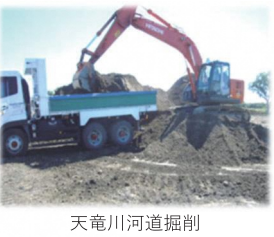
天竜川河道掘削
