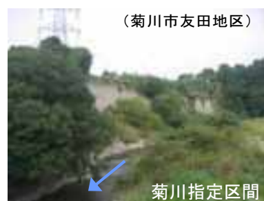
図 1-4 切り立った河岸の状況
