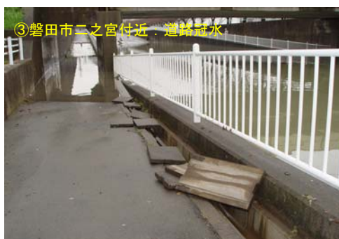
浸水状況写真 (平成 16 年 11 月 11～12 日洪水)
