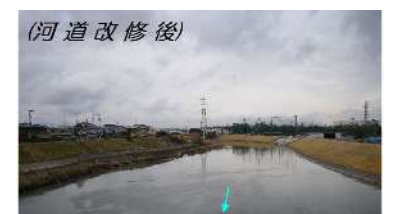
洪水を流下させるため、河道断面を大きく改修
